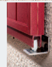
Guidage bas, olive sur équerre (volet aluminium)
